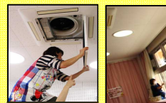
(換気扇の清掃)
